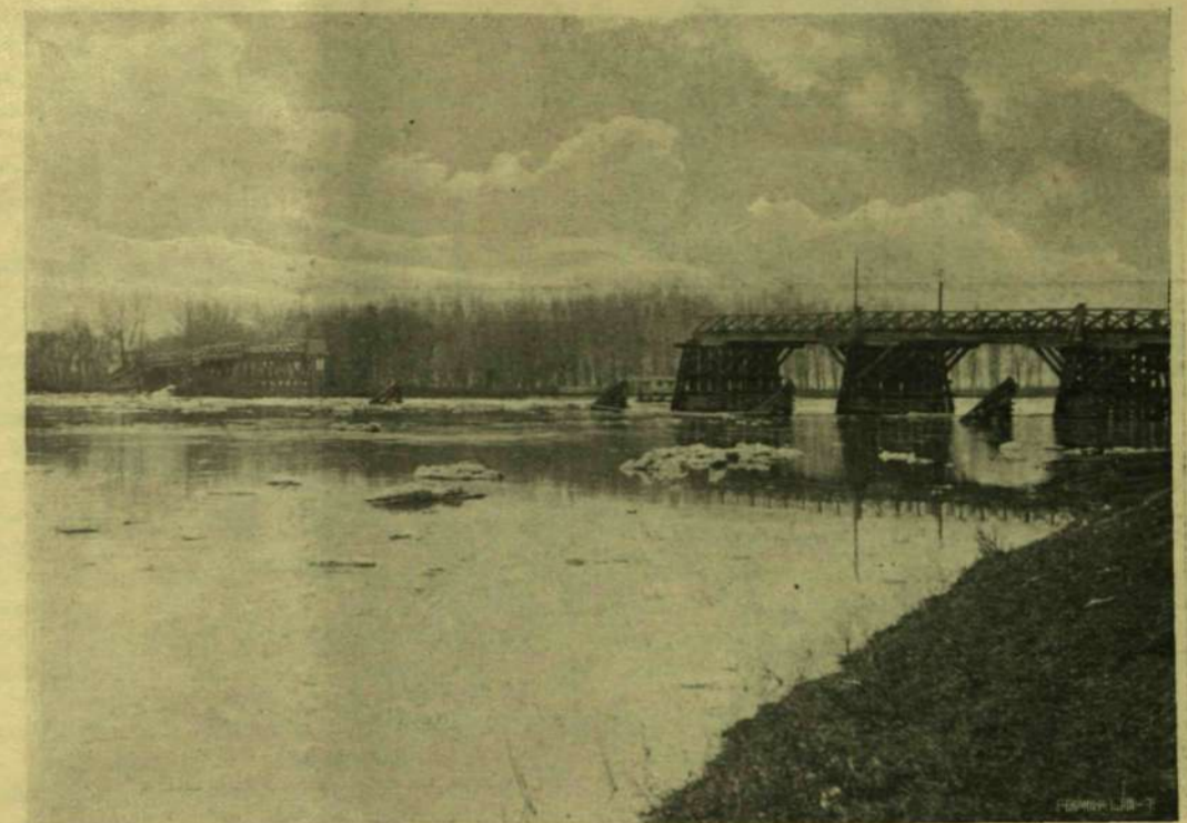
A LESZAKADT HÍD, BAL OLDALARÓL NÉZVE.
