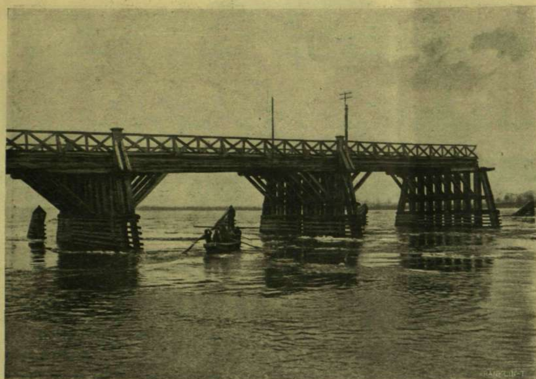
A LESZAKADT HÍD MEGMARADT RÉSZE.
