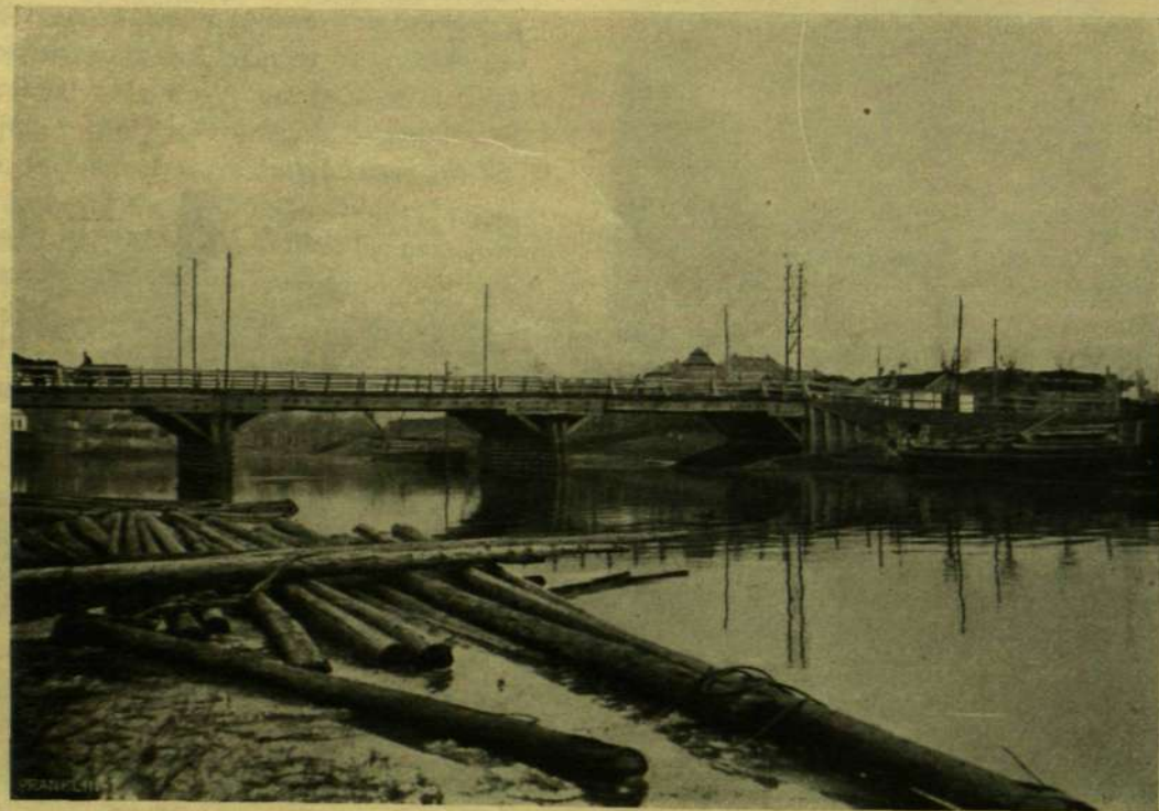
A ZAGYVA HÍDJA AZ ÁR ÁLTAL HOZZÁSODORT SZÁLFÁKKAL.
