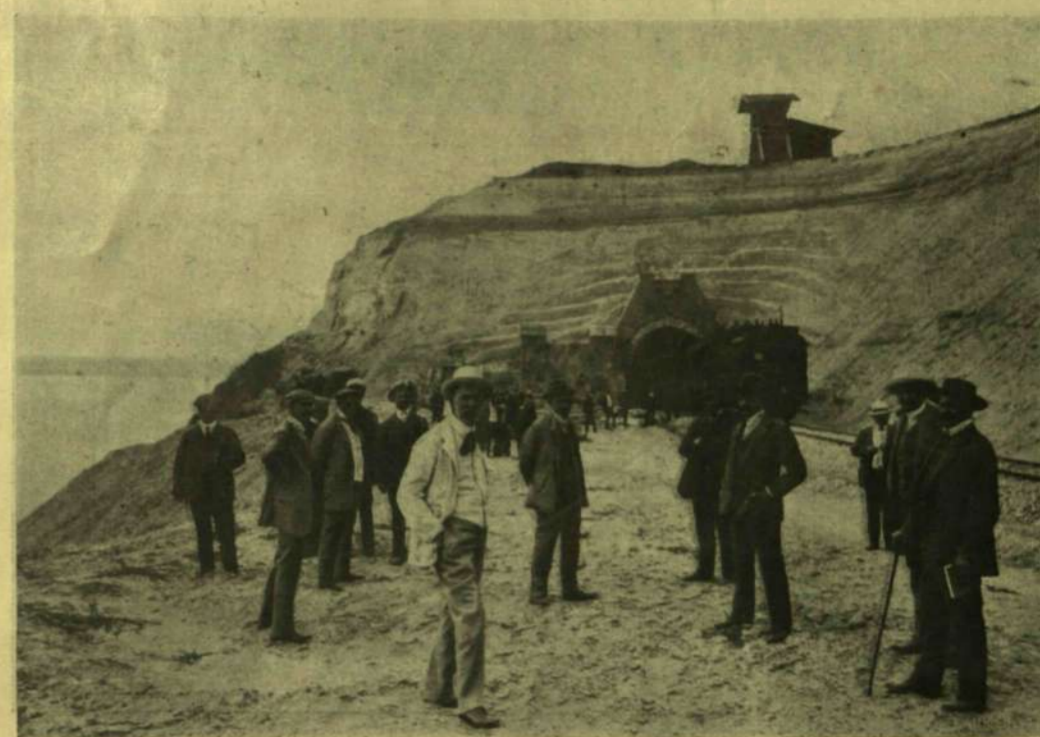
AZ ÚJ BALATONI VASÚT AKARATTYAI ALAGÚTJA ÉSZAK FELŐL.
