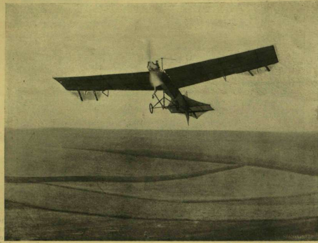
LATHAM REPÜLŐGÉPE, MELYLVEL ÁT AKART REPÜLNI A LA MANCHE CSATORNÁN.
