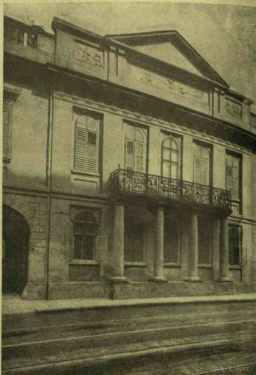
A PARNÖVELDE-UTCA 6. SZ. HÁZ HOMLOKZATA.
