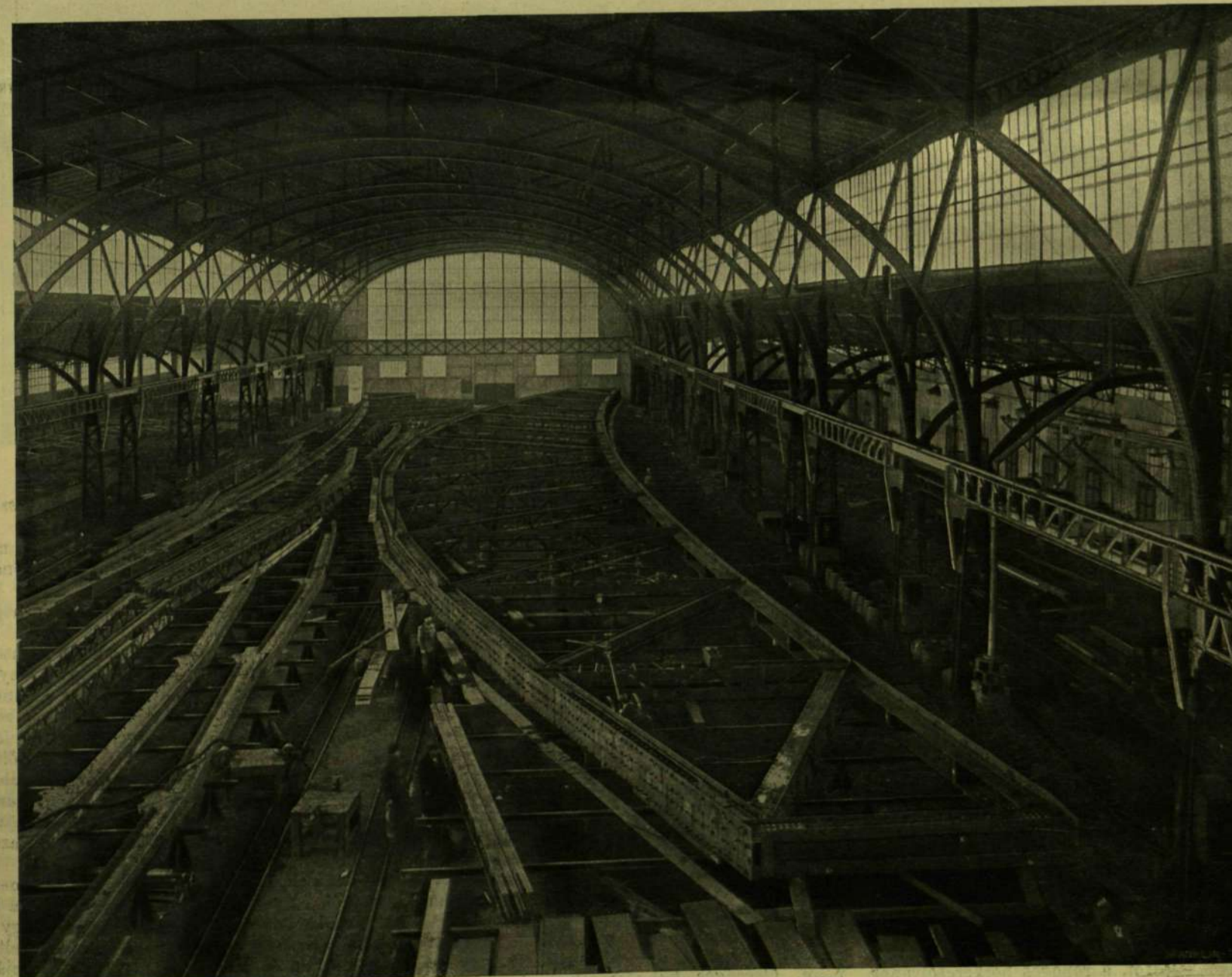
A HÍDSZERKEZET ÉPÍTÉSE AZ ÁLLAMVASUTAK BUDAPESTI GÉPGYÁRÁBAN.
