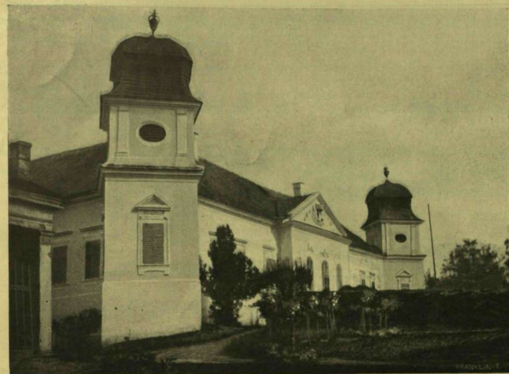
AZ ÚJ KASTÉLY HOMLOKZATA.
