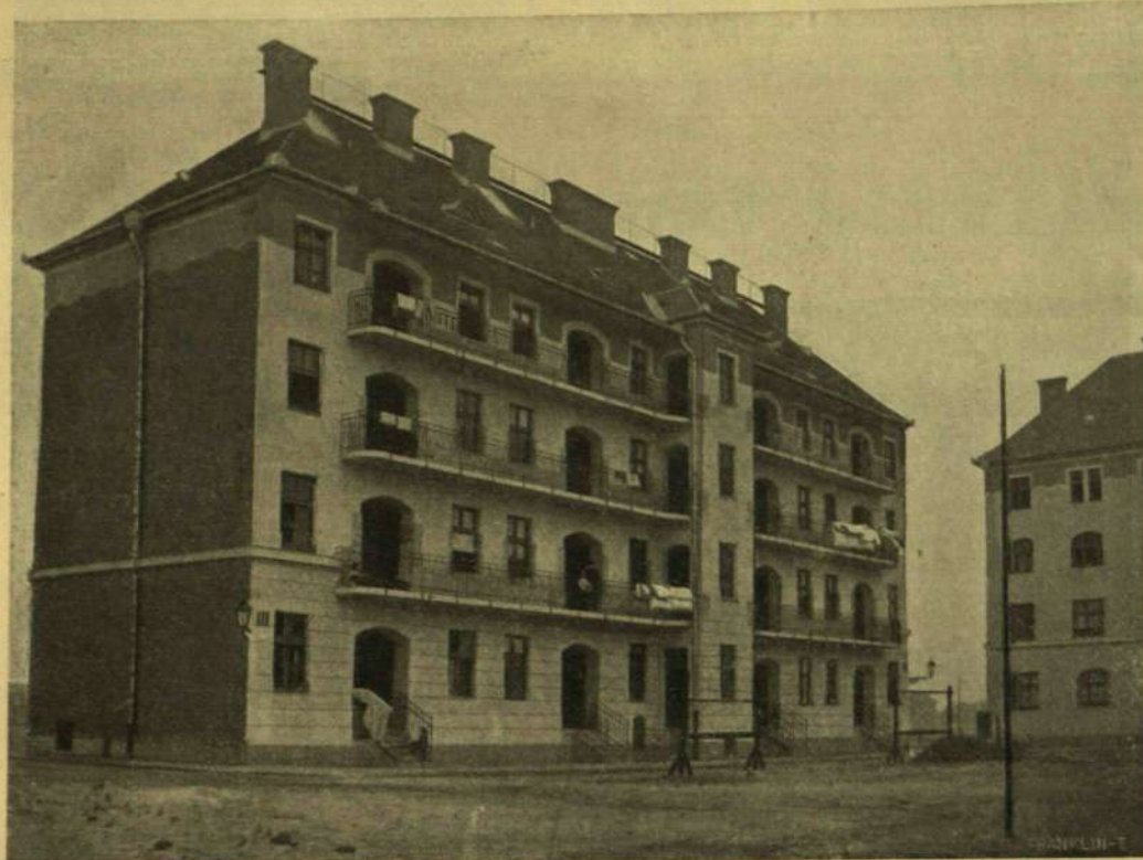
A GYŐRI-ÚTON ÉPÍTETT FŐVÁROSI MUNKÁSHÁZAK UDVARI RÉSZÉ.
