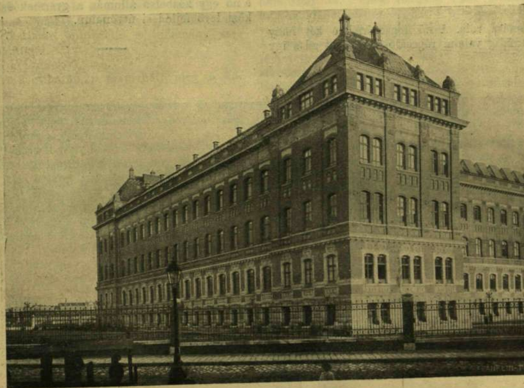
A KÖZPONTI ÉPÜLET EGYIK SZÁRNYÉPÜLETE.
