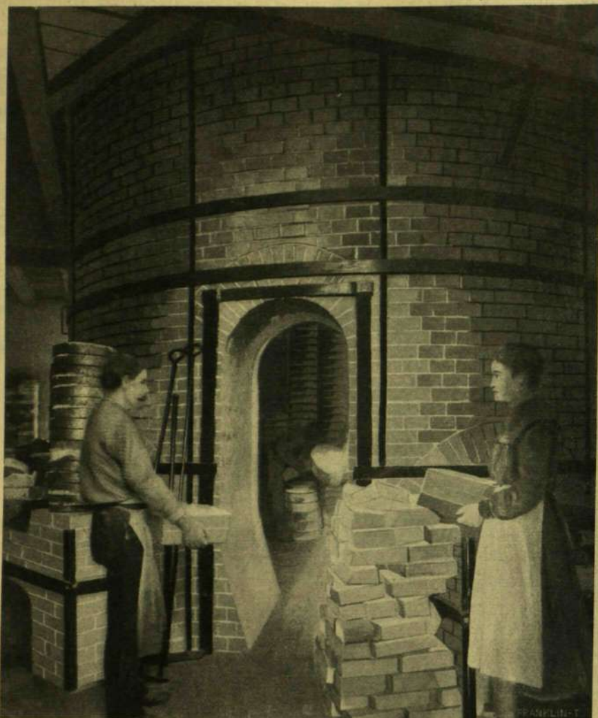
SÉVRESI TÍPUSÚ PORCELLÁN-ÉGETŐ KEMENCE.
