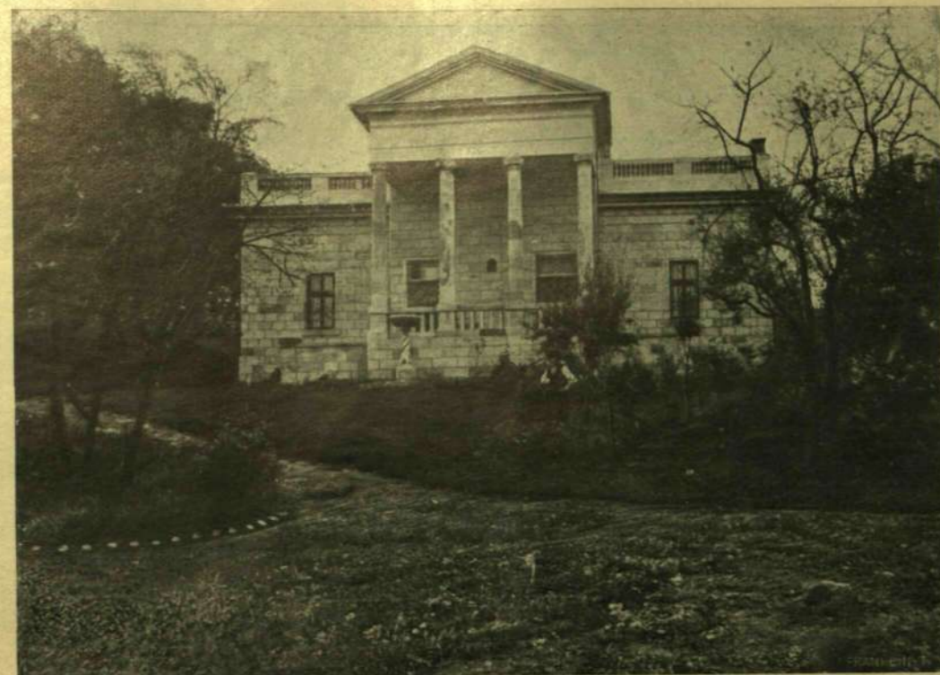
AZ ÚJ KASTÉLY HOMLOKZATA.
