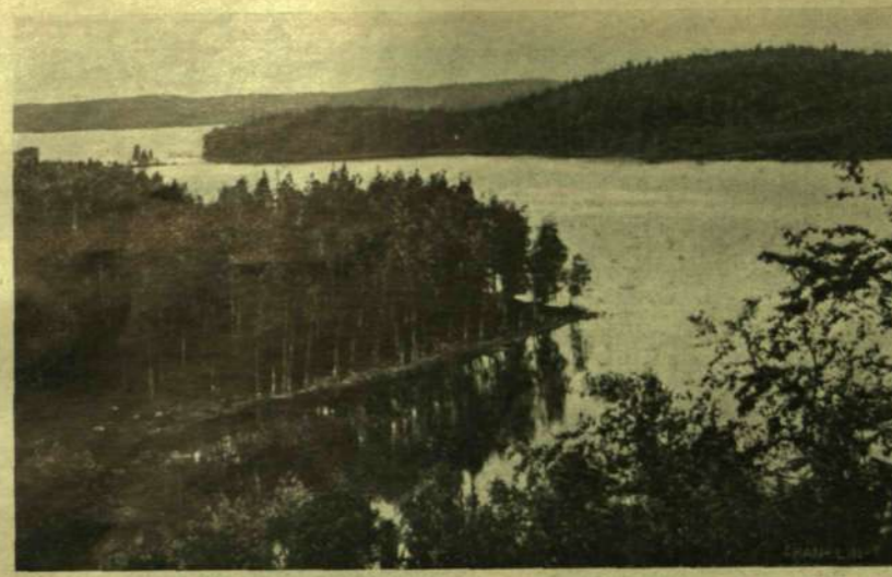
A KALKKISTEN CSATORNA ELEJE.
