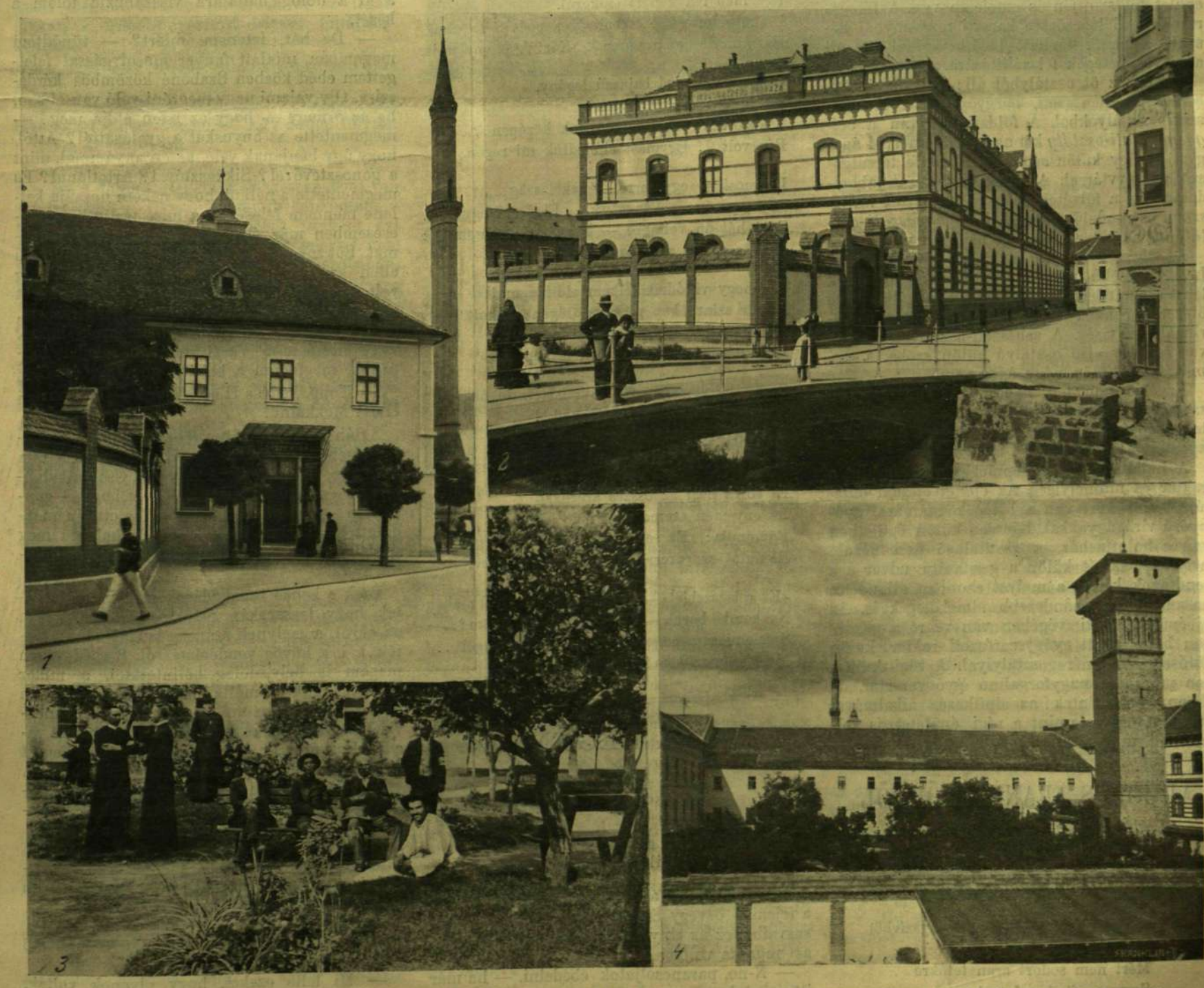
AZ IRGALMASOK EGRI KÓRHÁZA. — 1. Gyógyszertár a régi épületben, a minarettel. 2. Az új kórház főhomlokzata. 3. Az elmeegógyító intézet kertje. 4. A rend épülete a vistoromnyal.
