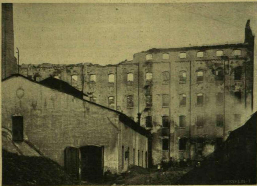
A leégett épület.
