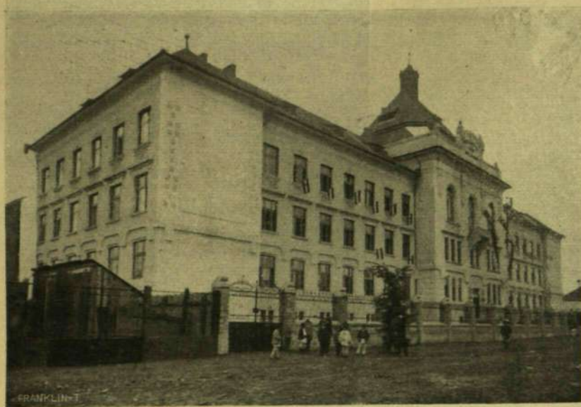
A KOLLÉGIUM ÚJ ÉPÜLETE.
