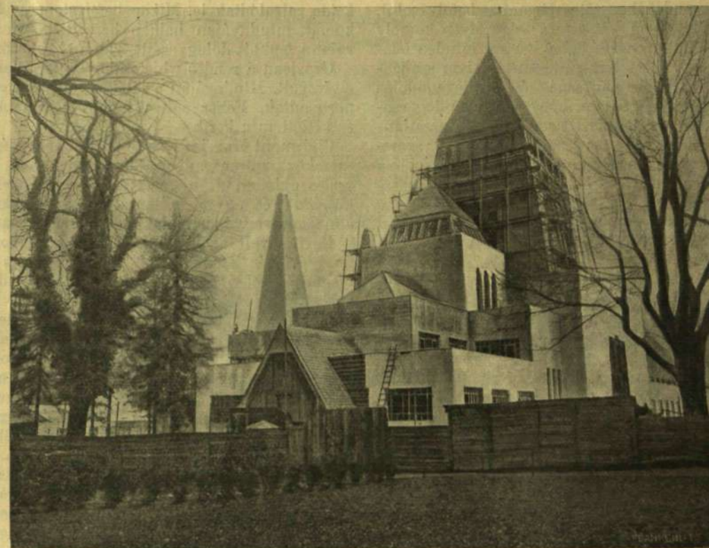
A TURINI NEMZETKÖZI KIÁLLÍTÁS ÉPÜLŐ MAGYAR PAVILLONJA.
