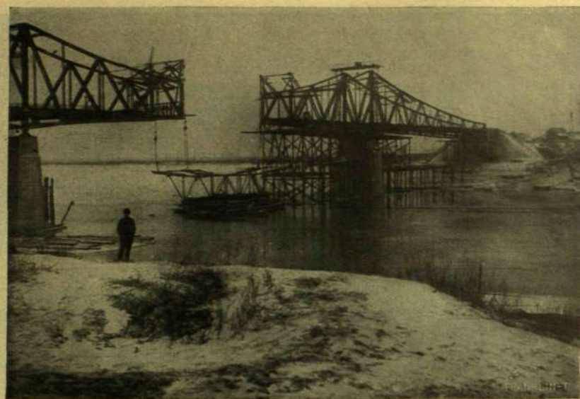
A híd középső része, beillesztésre előkészítve.
