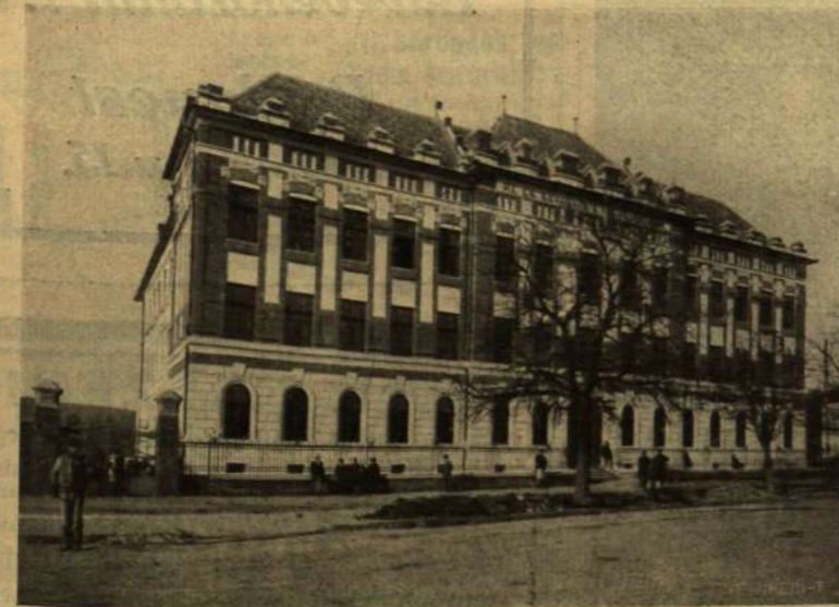
A KOLLEGIUMI FŐGIMNÁZIUM MOST FELAVATOTT ÚJ ÉPÜLETE.
