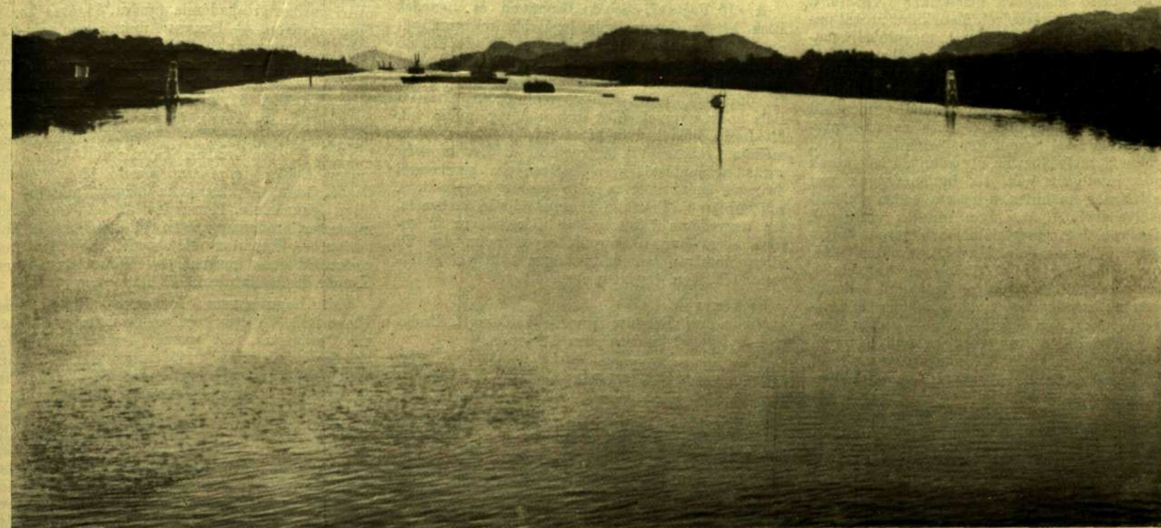
A PANAMA-CSATORNA ELKÉSZÜLT RÉSE, ÉSZAK FELŐL NÉZVE.
