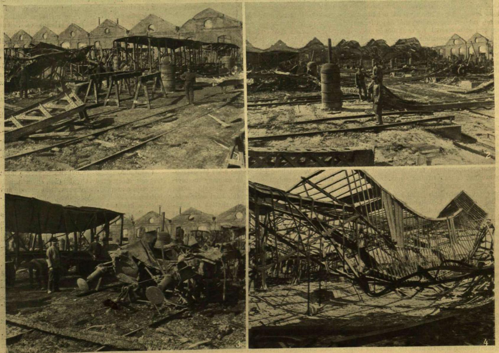
1. Elpusztult kocsik vázai. — 2. A forrasztó készülékek maradványai. — 3. Elpusztult kocsik. — 4. Az egyik csarnok vasszerkezete.
