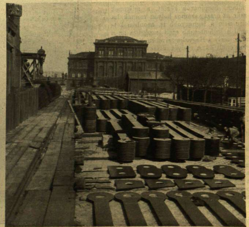
AZ ÚJ LÁNCZEMEK A PESTI OLDALON FÖLRAKTÁROZVA.
