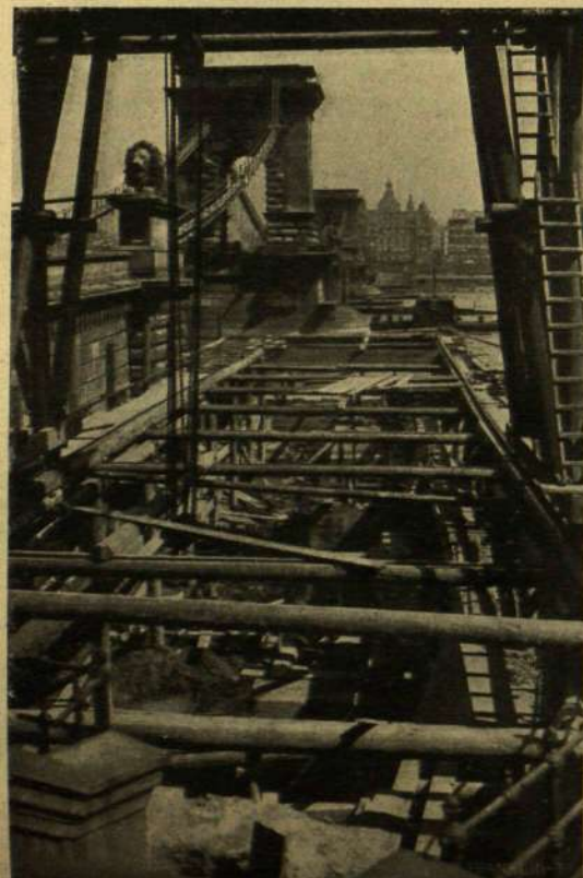
A HÍDFŐ MEGERŐSÍTÉSE.
