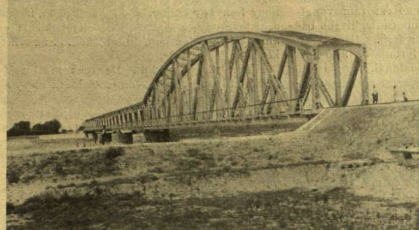
VASUTI HÍD ADANÁNÁL.
