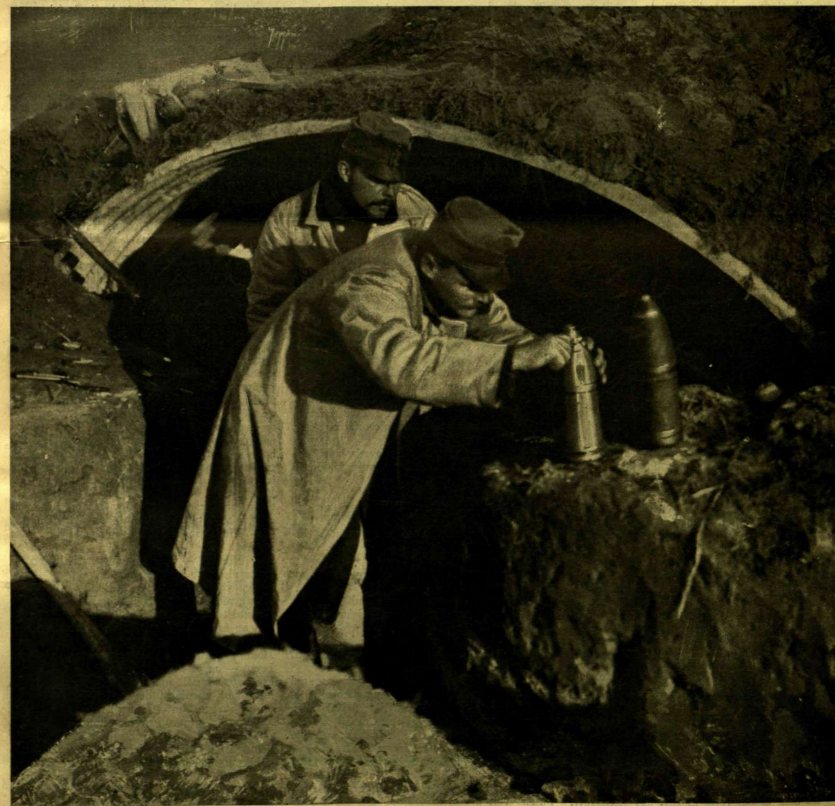
A SRAPNEL GYUJTÓZSINÓRJÁNAK BEIGAZÍTÁSA, HOGY A KELLŐ TÁVOLSÁGBAN ROBBANJON.
