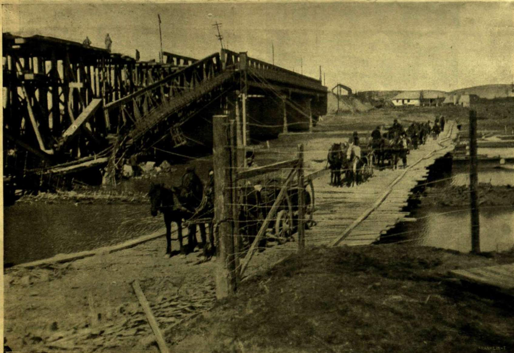
HELYREÁLLÍTÁS ALATT LEVŐ FELROBBANTOTT KÖZÜTI HÍD A PRUTHON (mellelte egy pontonokra épített szükség-híd).
