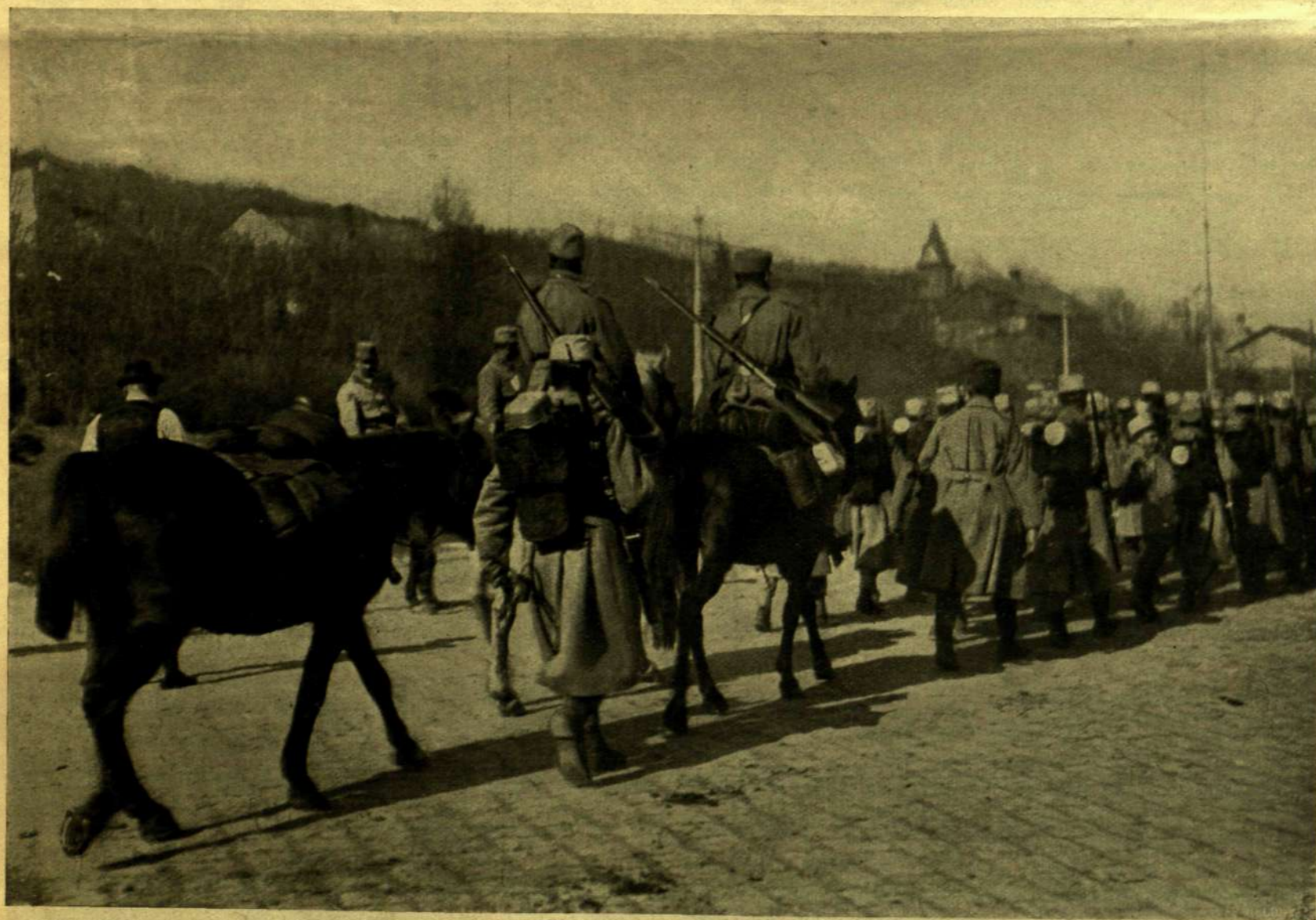
A FRISSEN FELSZERELT CSAPAT KIVONULÁSA CSERNOVICZBÓL A TŰZVONALBA.
