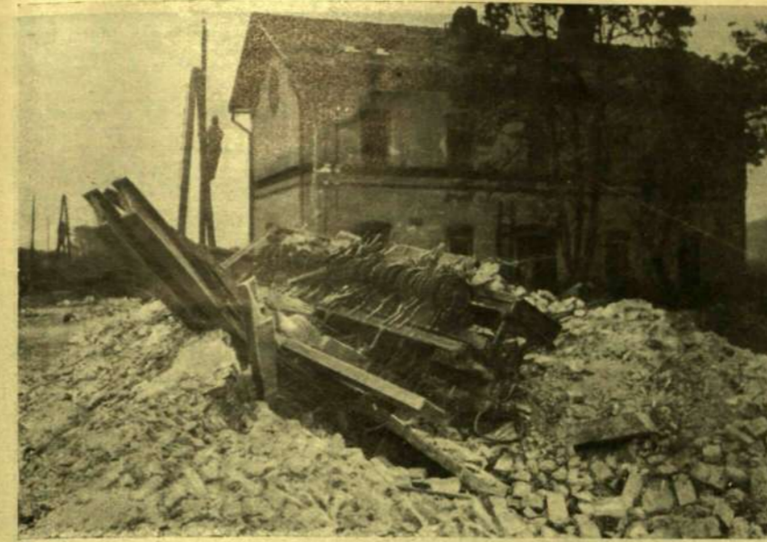
A tarnovi állomás váltóállító készüléke, melyet egy bomba kifordított a helyéből.
