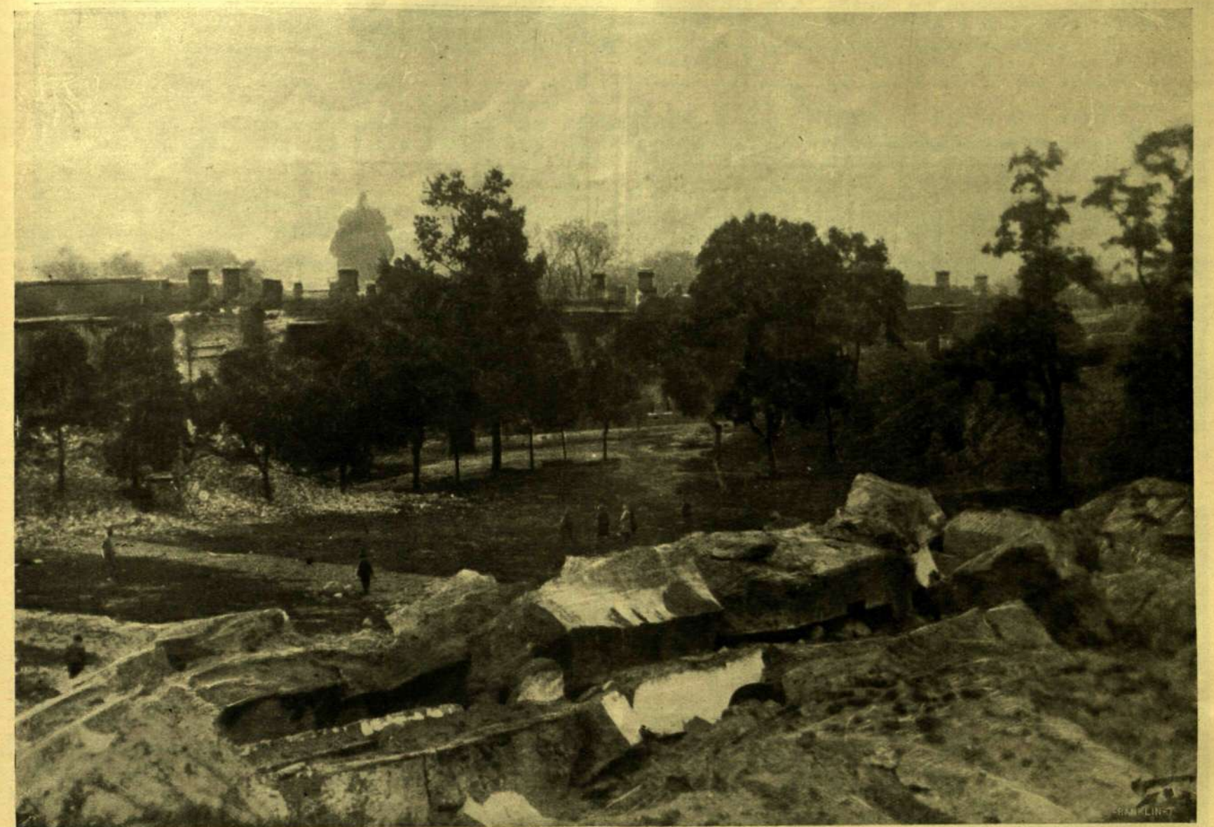
IVANGOROD ROMBADÓLT BETON VÉDMŰVE.
