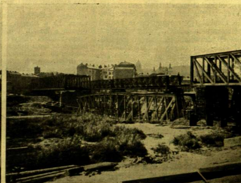
FELROBBANTOTT NAREV-HID OSTROLENKÁNÁL.
