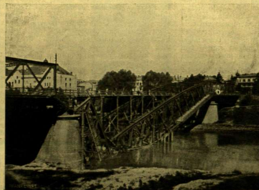
FELROBBANTOTT KÖZFORGALMI HID VLODAVÁNÁL.
