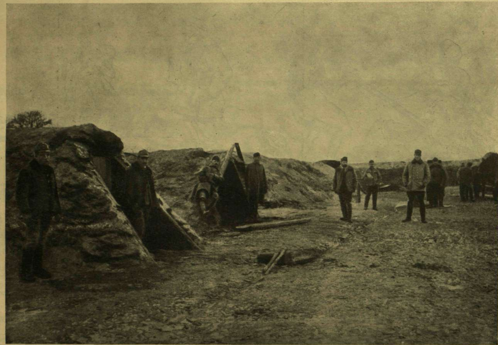
FÖLDKUNYHÓKBÓL ÉPÜLT FALU.
