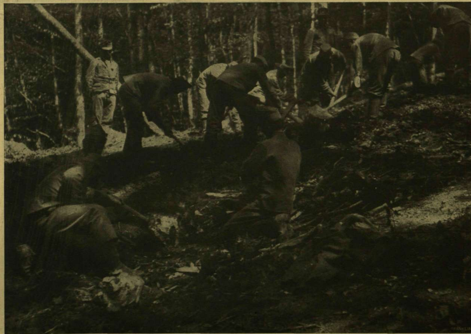
HADIUT ÉPÍTÉSE EGY ERDŐSÉGEN KERESZTÜL.
