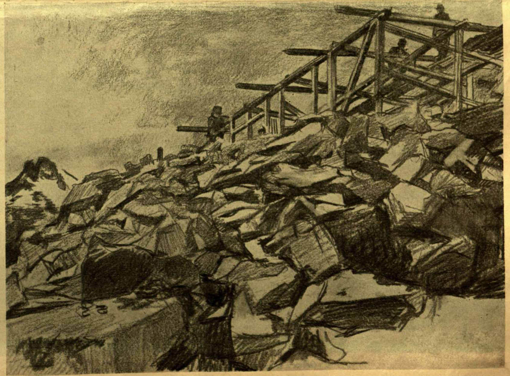
BARAKK-ÉPÍTÉS A DÉLNYUGATI HARCZTÉREN. — Frank Frigyes rajza.
