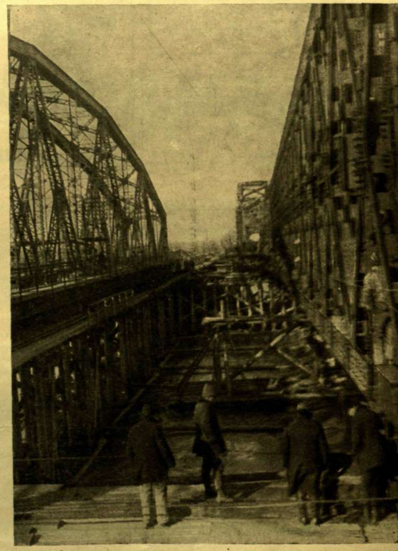
A RÉGI VASSZERKEZET RÉSZBEN KI VAN TOLVA, A BALRÓL LEVŐ ELKÉSZÜLT ÚJ HID ANNAK HELYÉBE KERÜL.
