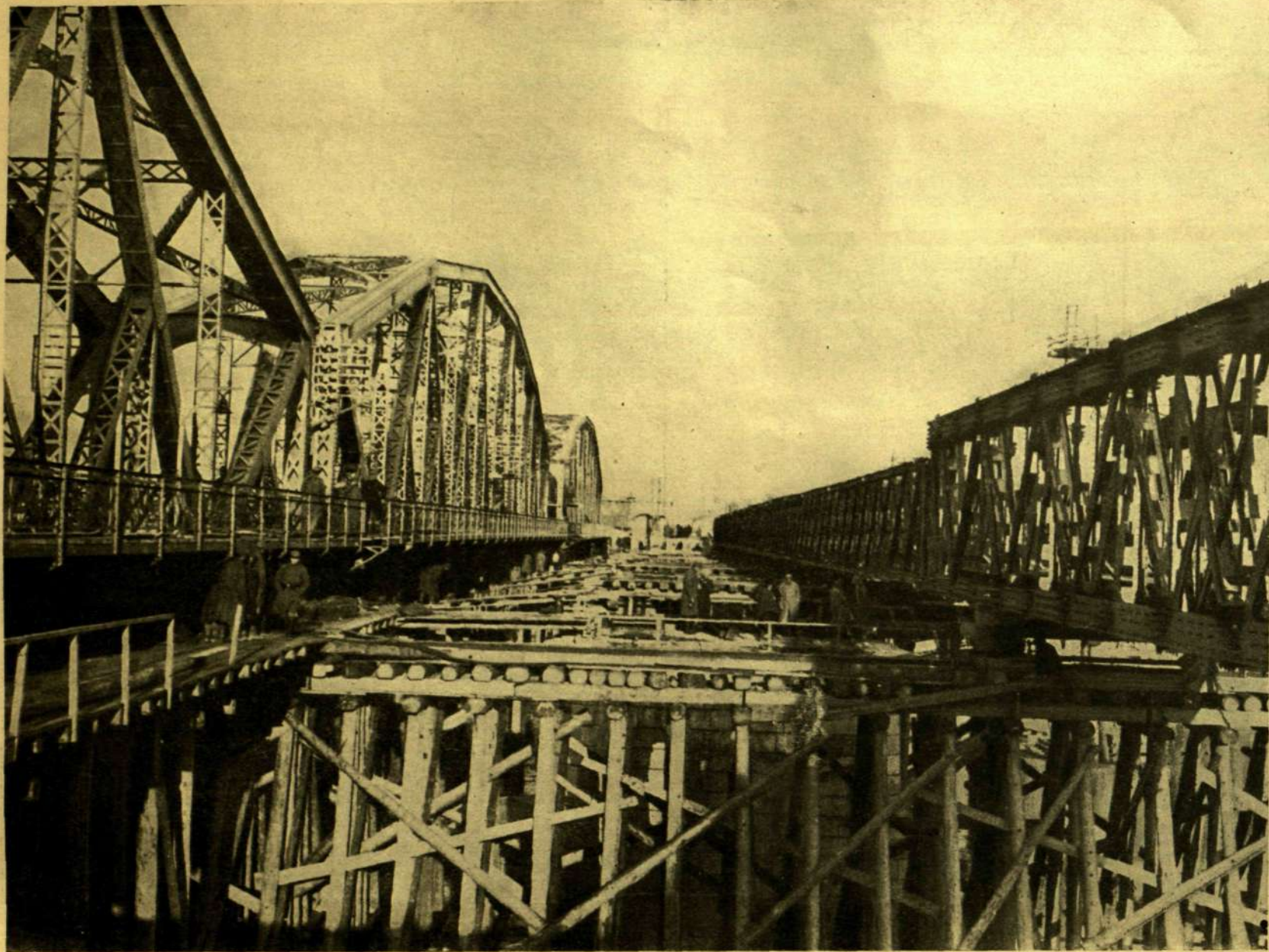
A RÉGI IDEIGLENES HIDAK, S BALRÓL AZ ELKÉSZÜLT ÚJ HIDAK A BETOLÁS ELŐTT.
