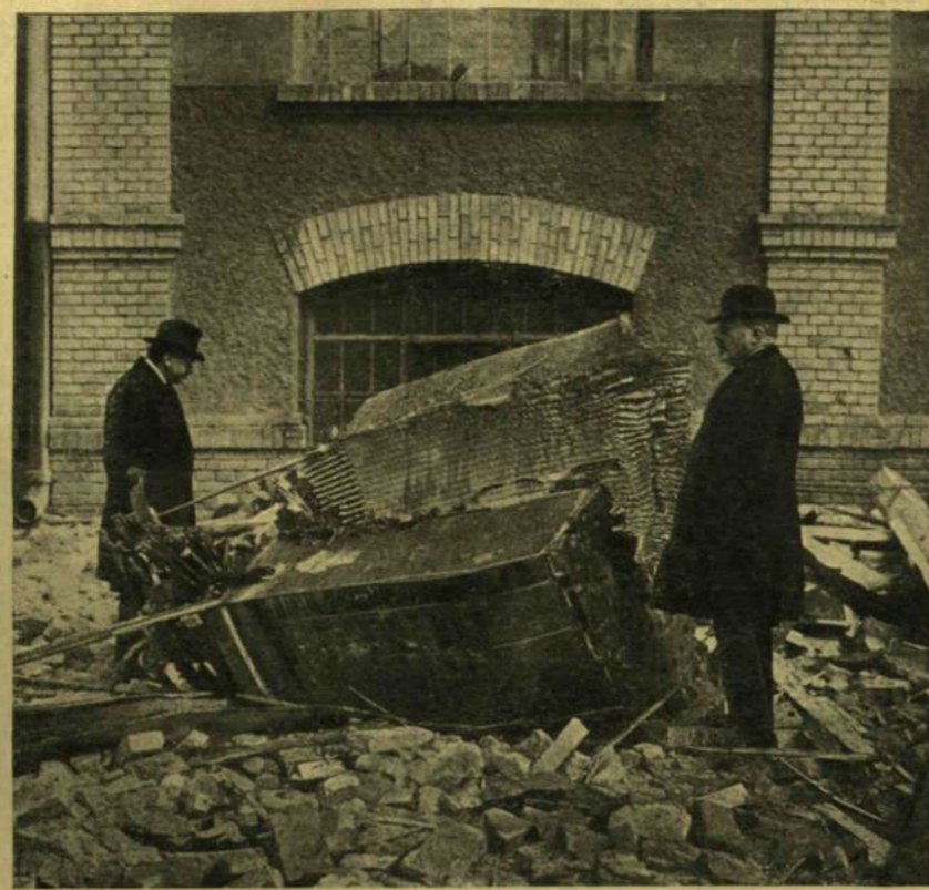
AZ UTCÁRA DOBOTT ELEKTROGENERATOR.
