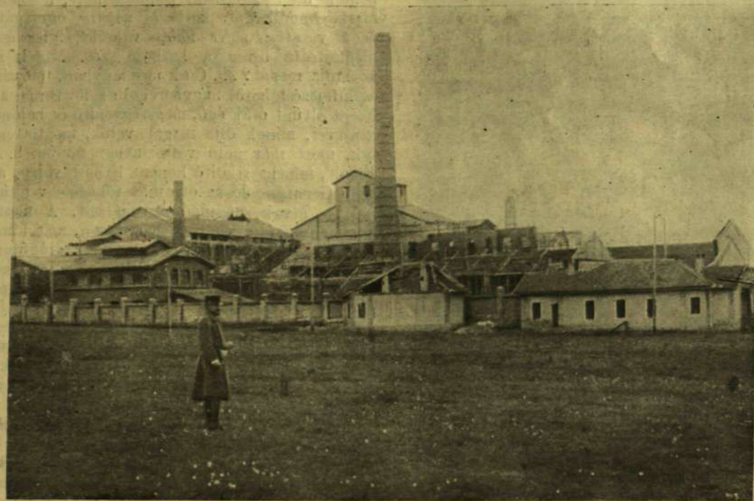
AZ ÉPÜLŐ CZUKORGYÁR.
