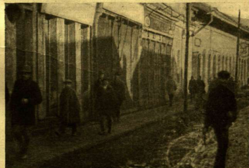
SALGÓTARJÁNI UTCA A ZAVARGÁSOK UTÁN.
