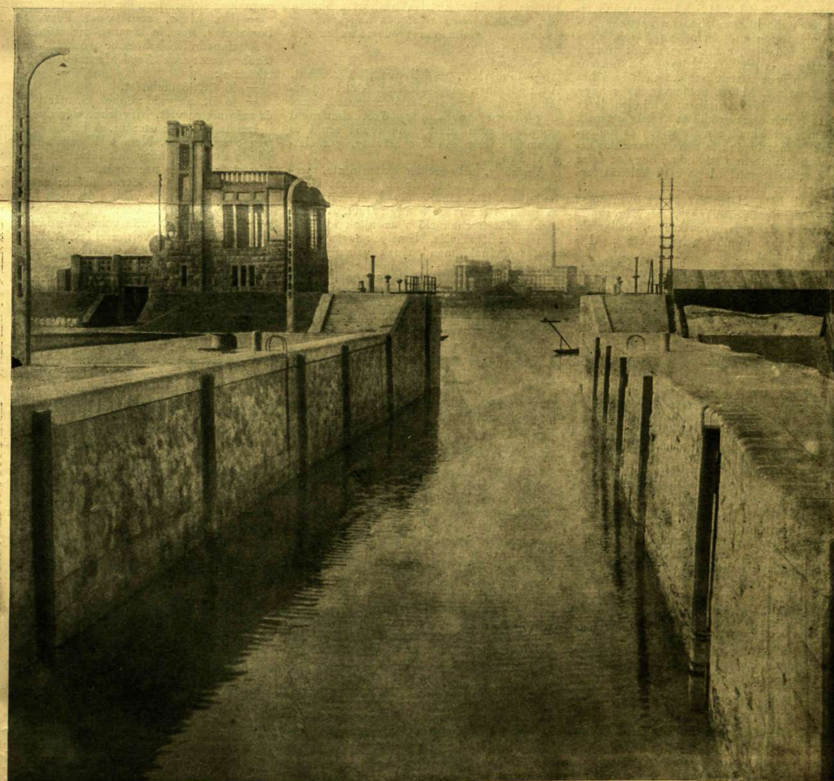
A FELSŐ BUDAPESTI KAMARAZSILIP A KÖZPONTI VILLAMOS BERENDEZÉSŰ KAPCSOLÓHÁZZAL. A SOROKSÁRI DUNA-ÁG SZABÁLYOZÁSÁNAK ÉPÍTKEZÉSE.
