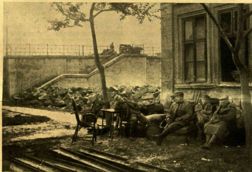
A SZOLNOKI KÖZÜTI HÍD VÉDELMI ÁLLÁSA A LEGUTÓBBI SIKERES TÁMADÁSOK ELŐTT.
