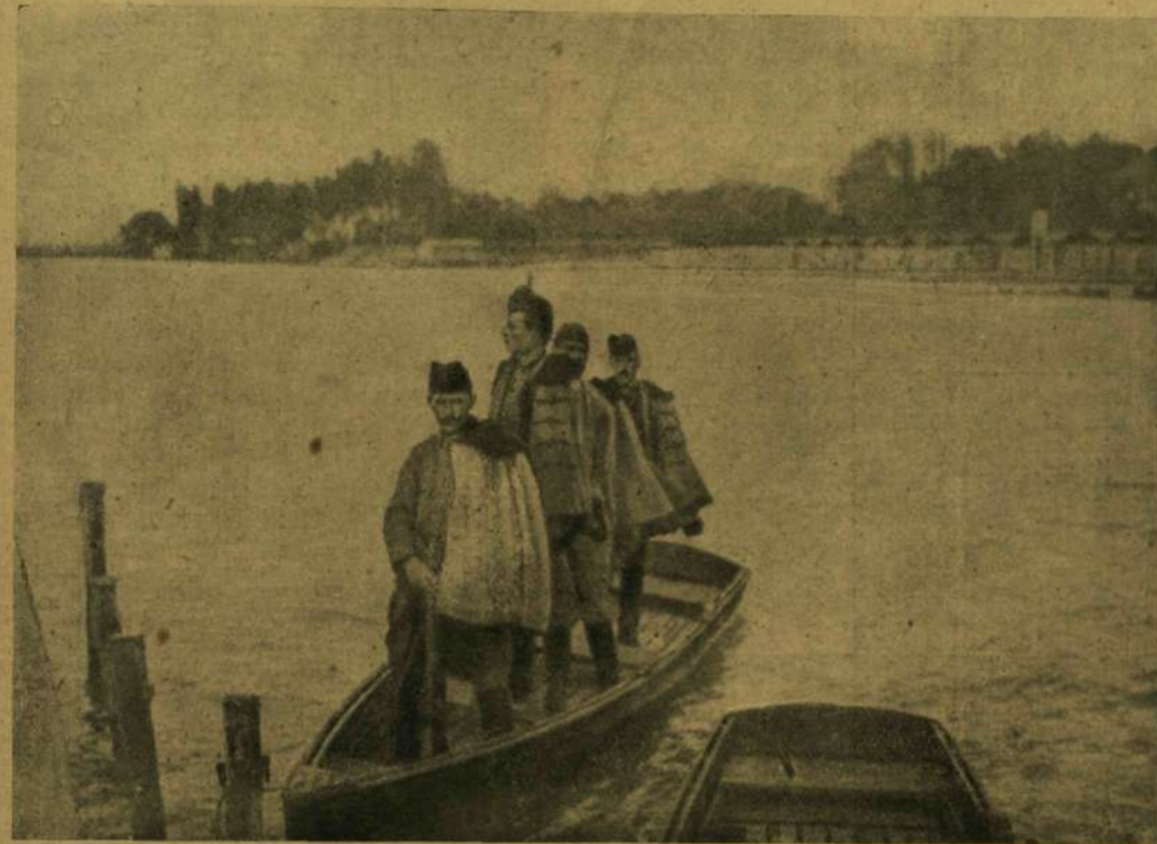
HUSZÁR JÁRÓR A BALATONON.
