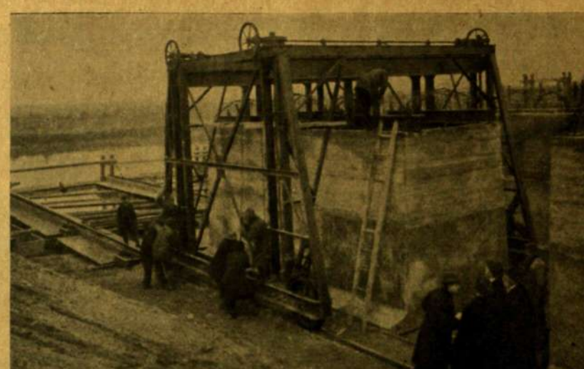
VASBETON SZEKRENYEK FELEMELÉSE ÉS A VIZRE SZÁLLÍTÁSA.
