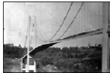
b) A rezgő hidat az oldalirányú szél megcsavarta
