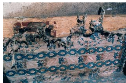
56. kép. A zár körül leszakadt, hiányos, ki-rojtosodott vászon
