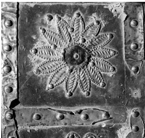
15. kép. Sérült, hiányos, szennyezett rézlemez a tetőn
