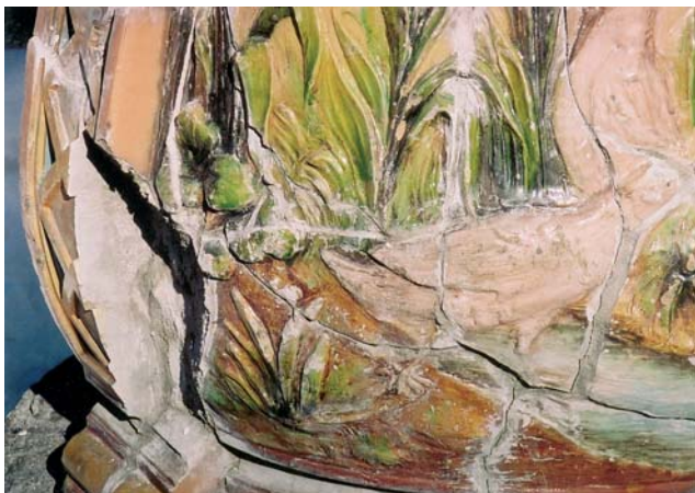
8. kép. Cementtel rosszul összeragasztott, sérült szökőkút részlete
