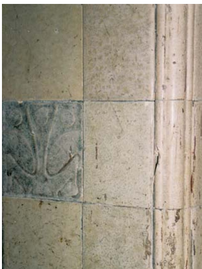
10. kép. Sérült és festékkal szennyezett fuga nélkül rakott, összecsiszolt csempék, Gresham palota, Budapest
