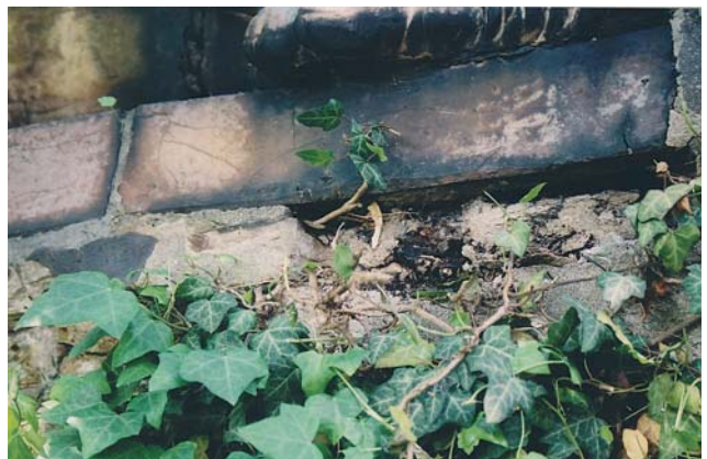
7. kép. Az borostyán erős gyökérzetével és kacsáival szétfeszíti a kerámia elemeket
