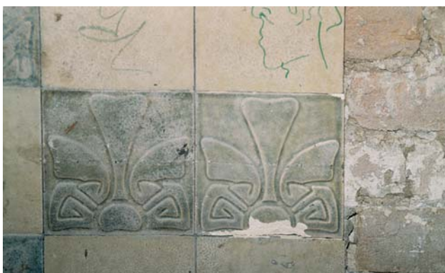
8. kép. Cementtel rosszul összeragasztott, sérült szökőkút részlete
