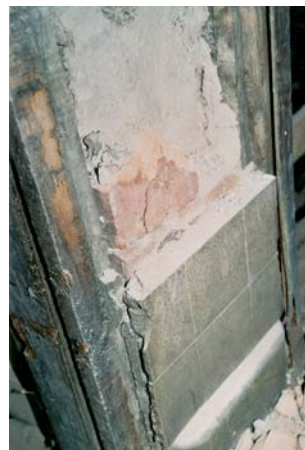
12. kép. A magas hátsó kávájú csempék a cementes vakolattal együtt válnak el a faltól Gresham palota, Budapest
