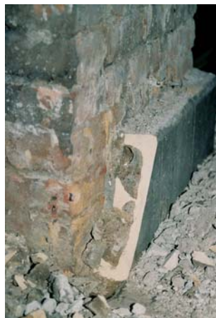
11. kép. A lábazat csempék keresztmetszete, Gresham palota, Budapest
