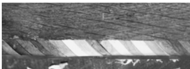
19. a-b. ábra. A fejelőléc díszítésének hiányai és kiegészítésük.
