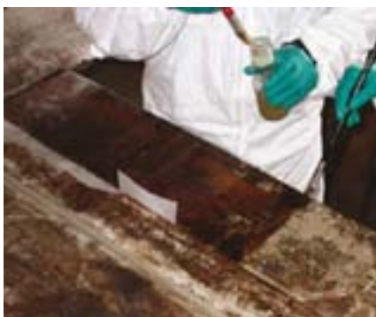
114. kép. A pergő és porlékony festékréteg megkötése halenyvvel.
