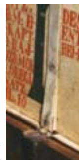
34. kép. A vaspánt kiékelése.
