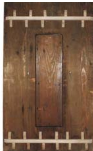
51. kép. A téka hátoldala az új csúszóhevederrel.
