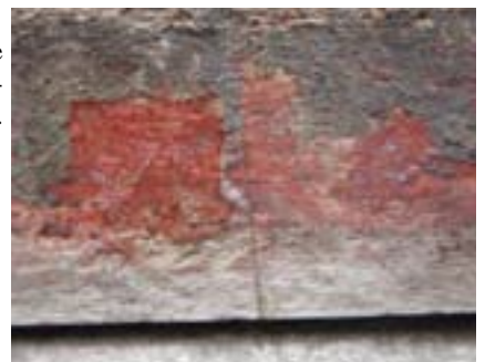
110. kép. A festésre „cementálódott” vas- tag szennyeződés.
