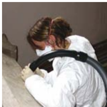
113. kép. A felületi szennyeződés eltávolítása porszívóval.
