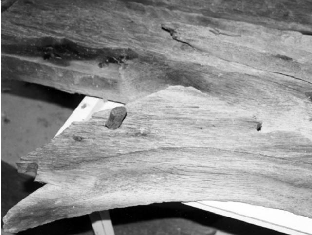
5. kép. A gyalogkapu bal oldali, megmaradt hónalj kötés.
