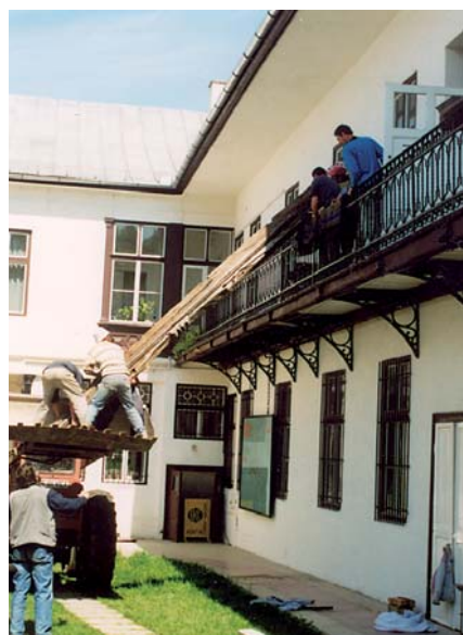
16.kép. A kapuelemek beemelése a kiállítóterembe.
