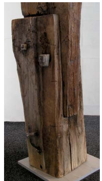
13. kép. A gyalogkapu jobb oldali zábéjának ráklábázása, a nyílók vasalatával.
