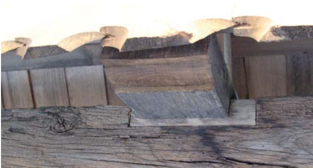
11. kép. A kontyfaban végzett kiegészítés (beillesztés), és az új keresztgerenda.
