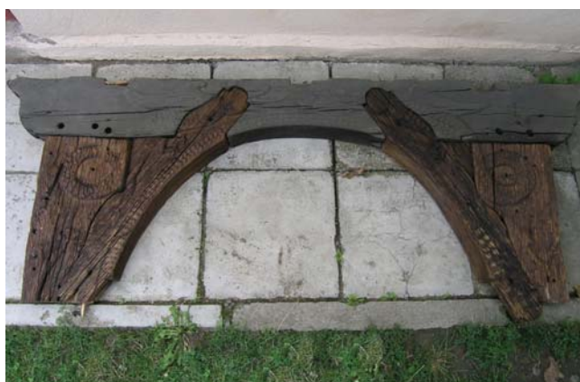
18. kép. Cinteremkapu eredeti részei restaurálás közben, felül a még nem tisztított, alul a tisztított felület.
