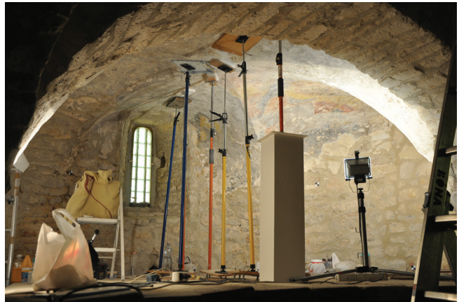
9. kép. Nagyszámú prés egyszerre történő alkalmazása a sok elválás miatt.
