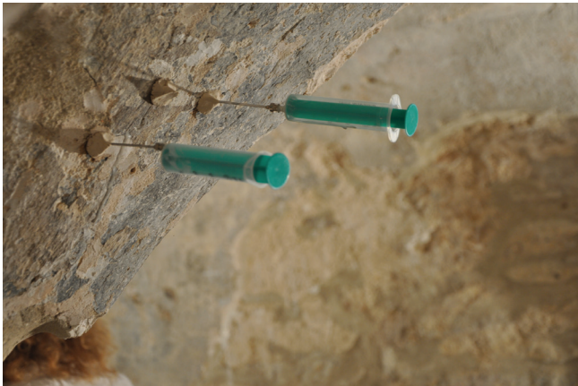
7. kép. A nyomással való injektálás idejére kaolinnal szigetelt nyílások a tűk mellett, és ahol az anyag előtört a bepréselés során.
