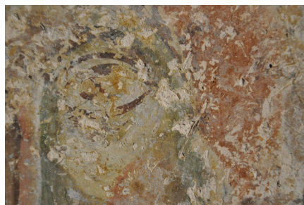
3. kép. A töltőanyagként növényi vagdalékot tartalmazó vakolat. A kipergett pelyva és szalmaszálak helyei, valamint egy szalmaszál egy kisebb sérülésnél.
