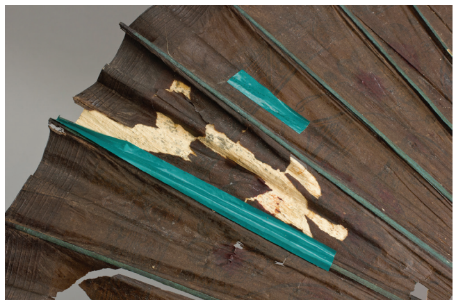
13. kép. Papírvajítás és szigetelőszalagos rögzítések a kupolán (Nyíri Gábor felvétele).
