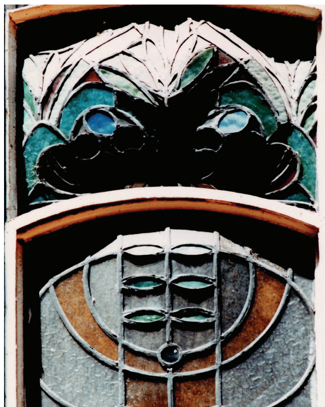
7. kép. Légnymástól deformálódott ablakrész, Gresham-palota, Kossuth lépcsőház, RóthMiksa műhely, 1906.
