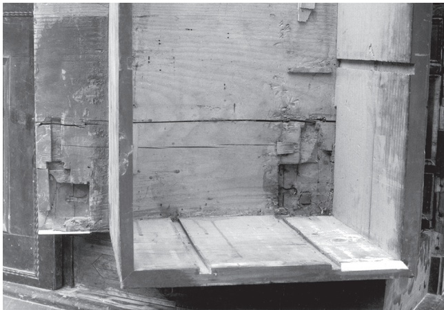
3. kép. A forgatható dobozok zárszerkezeteinek bevészt helyei (Kolozs Ágnes felvétele).
