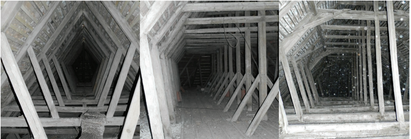
9. kép. Jellegzetes tetőszerkezeti megoldások a 18. század végéről, 19. század elejéről: (1) Bodos, (2) Bita, (3) Étfalva (a szerző felvételei, (1) 2017, (2) 2015, (3) 2015).
