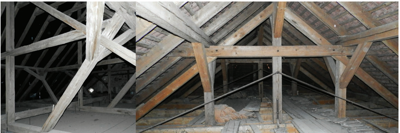
10. kép. Jellegzetes tetőszerkezeti megoldások a 19-20. századból: (1) Bikfalva, (2) Vajnafalva (a szerző felvételei, (1) 2015, (2) 2017).
