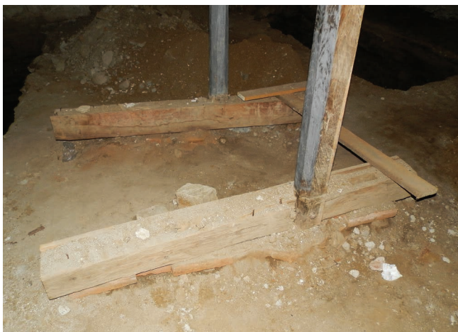
4. kép. A feldobolyi templom nyugati karzatának papucsfái (a szerző felvétele, 2017).
