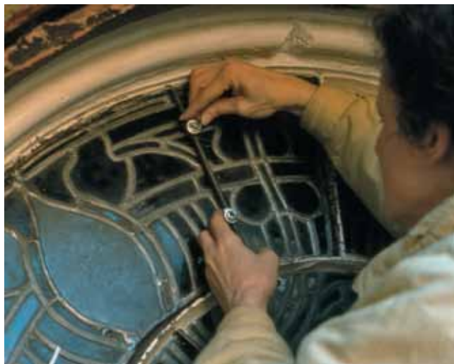
19. kép. Merevítővasak rögzítésére szolgáló rózsakötés készítése.
