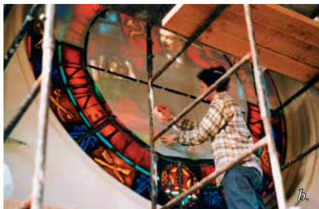
1. a. kép. Egy Patrona Hungariae üvegfestmény helyére 1947-ben helyezett Lenin-ablak. b. A Lenin-ablak lementése 1991-ben. Kiemelés előtt az egyes ablakrészek átrajzolása pausz papírra.
