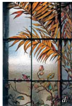
13. kép. Budapest, V. Báthori u. 4. Volt főúri lakás fogadószobája üvegfestményeinek restaurálása a korrodálódott ólomsínek cseréjével, a hiányzó üvegszárak rekonstrukciójával. a. Restaurálás előtti állapot. b. Az üvegszárak teljes szétbontása, az ólomsínek eltávolítása. c. A hiányzó üvegszárak megfestése az eredeti festéstechnikával. d. A restaurált, részben rekonstruált üvegfestmény részlete.
