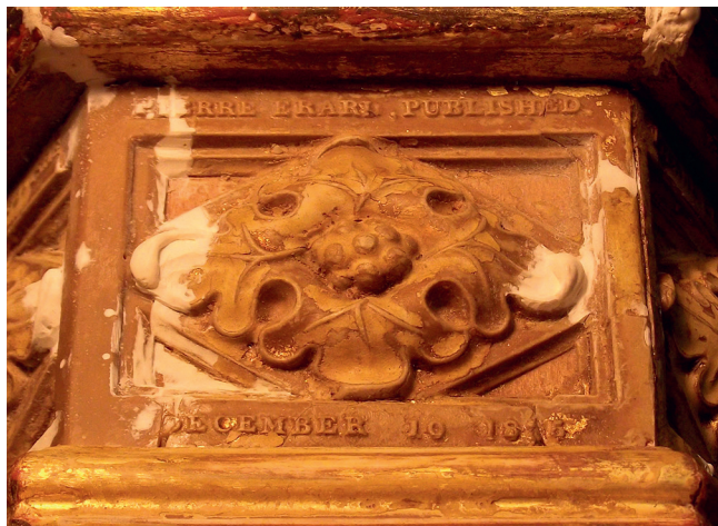
22. kép. A blondeltechnika mellett a kisebb hiányok pótlásánál az enyveskréta is szerephez jutott
