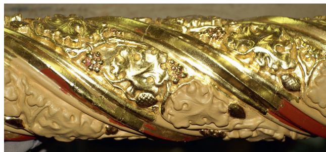
33. kép. Fény és mattaranyozások az oszlopon, munka közben
