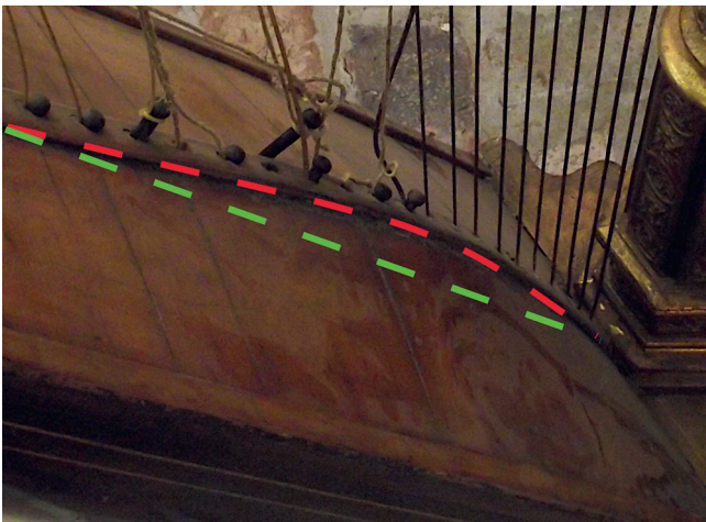
26. kép. A basszus rész fémhúrjai által kifejtett húzóerő következtében a rezonátor és a húrtartók maradandó deformitást szenvedtek
