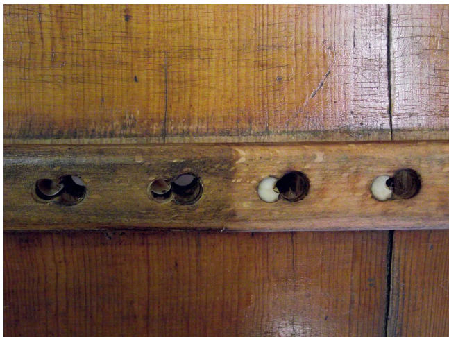
31. kép. A lakkozott felületek tisztítása Vulpex oldattal
