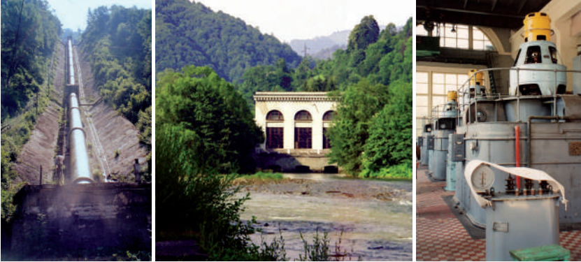
A víztárolóból az alagúton át a hegyoldalban megépített csövön érkezik a víz a Nagyágba. A turbinaház. A három turbina felső, áramfejlesztő része. (A szerző felvételei)
