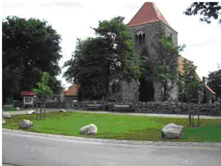
19. sz. projekt, a kirchwahlingeni faluközpont felújítása Niedersachsenben
